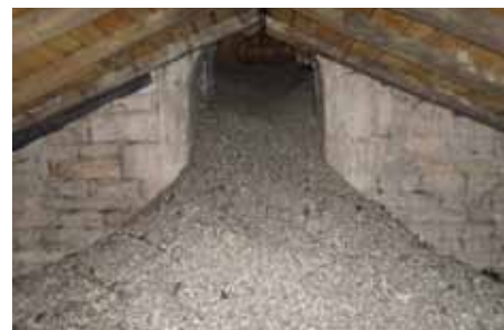
Déblayage du clocher de l'Abbaye
